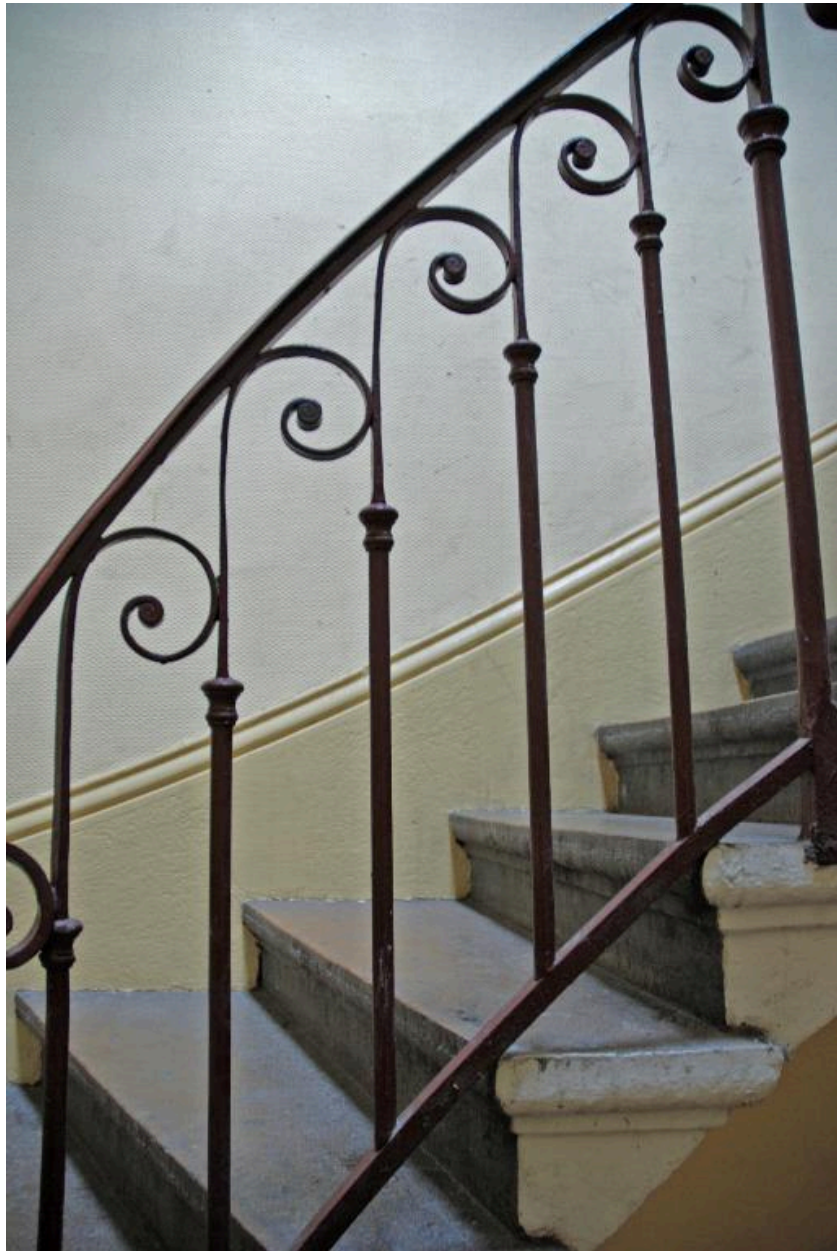
Détail du garde-corps de l'escalier
