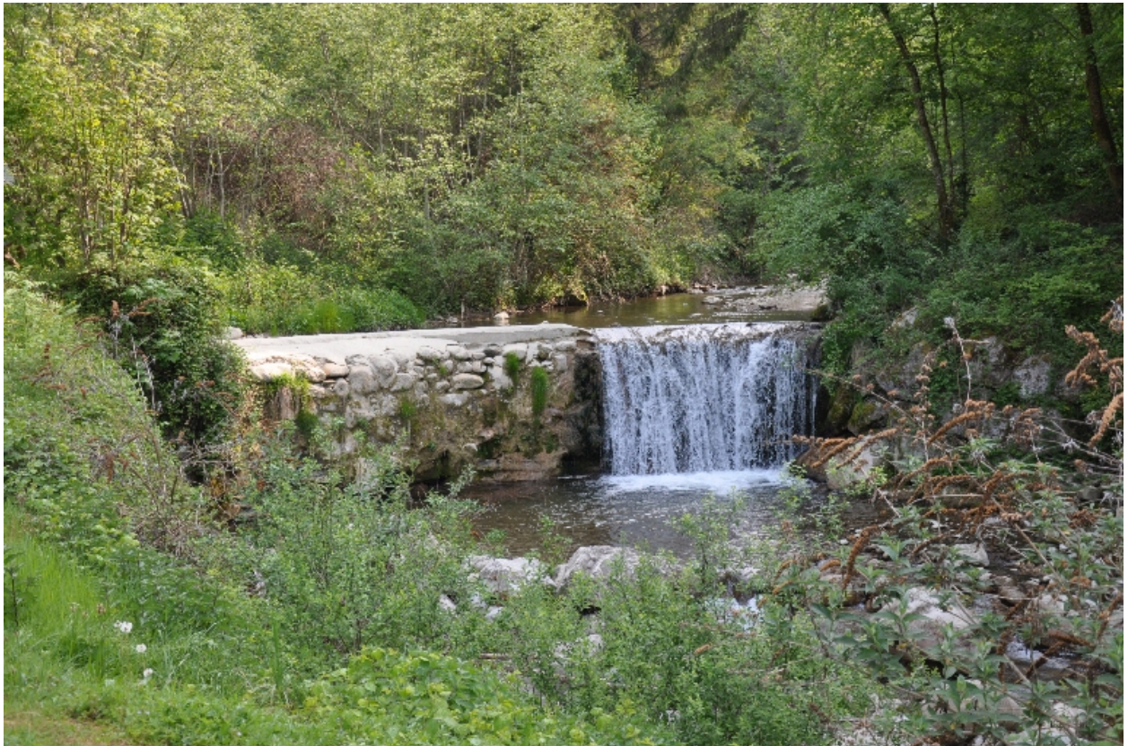
Vue du barrage sur sur la rivière le Sierroz .
