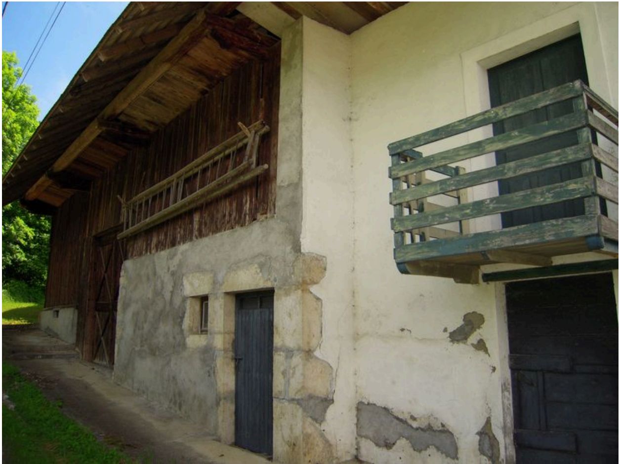
Vue de la façade nord.
