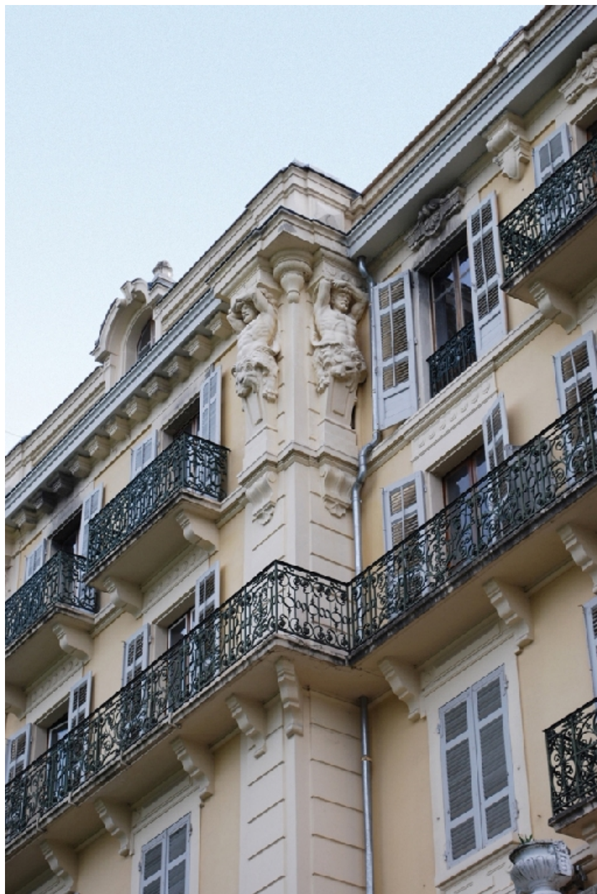
Détail de la façade ouest
