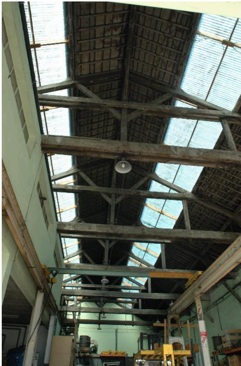
Vue de la charpente en béton
