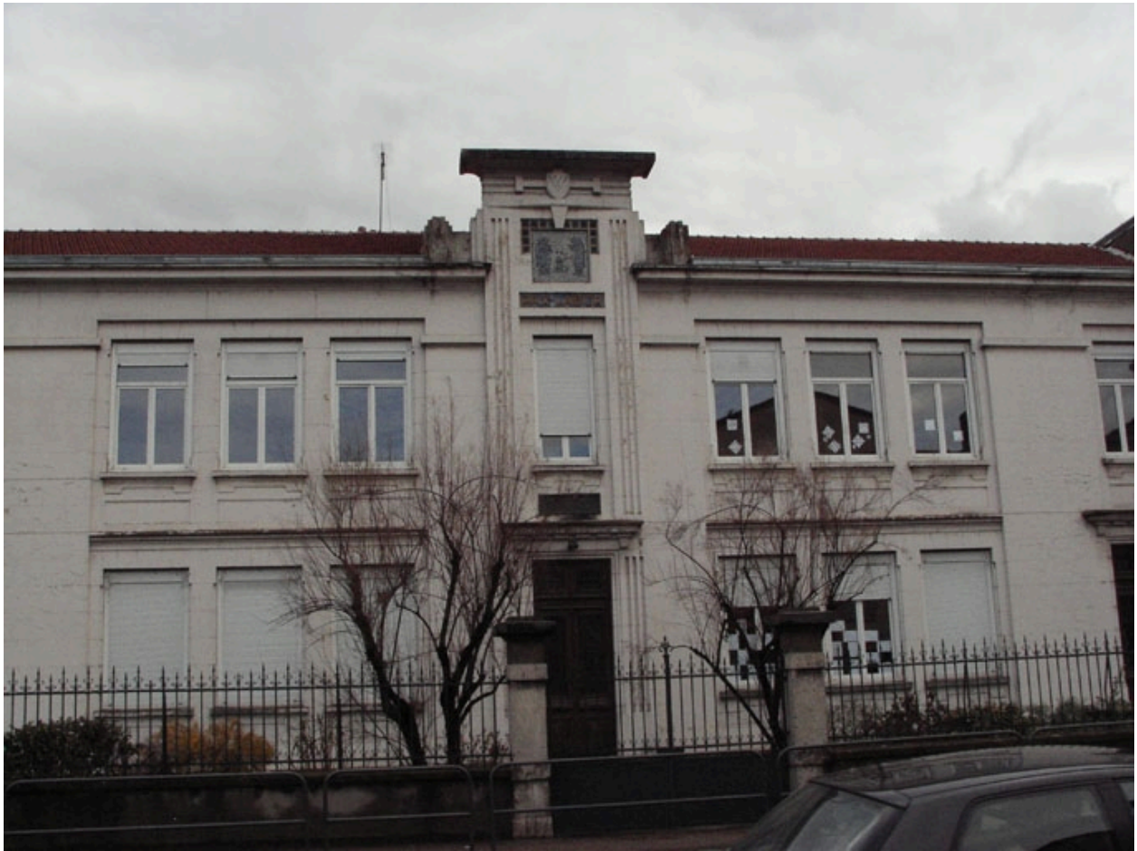
Corps central et entrée principale
