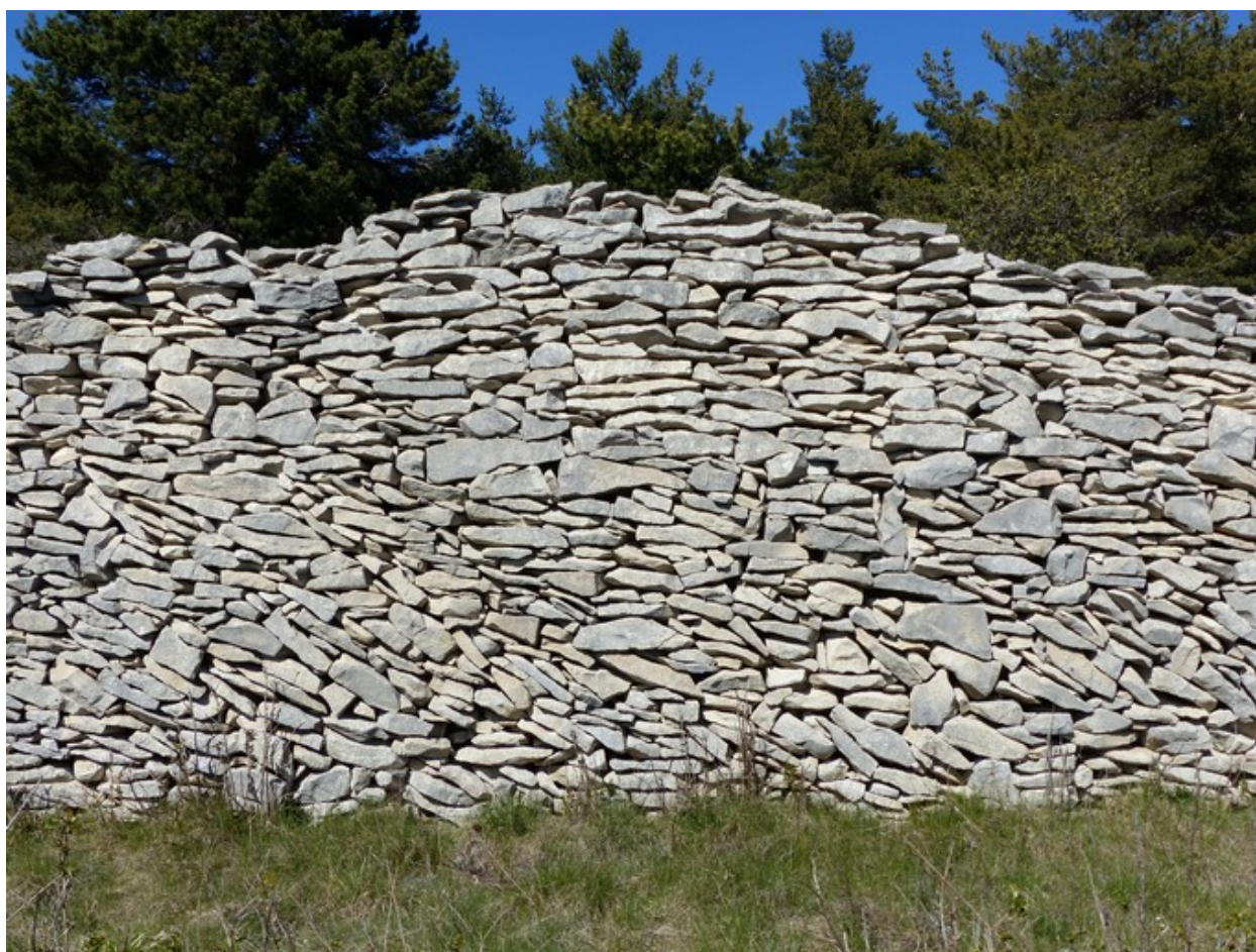
Maçonnerie en pierre sèche d'une bergerie. Quartier du Farnet.
