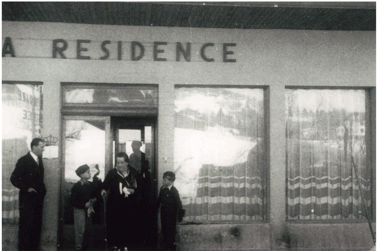
Entrée de l'hôtel. Photogr., 1938
