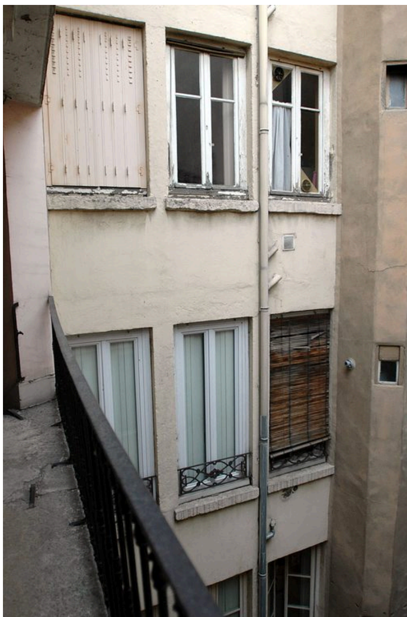
Corps de bâtiment principal : élévation sur cour
