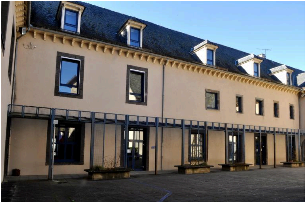
Cour sud, élévation du corps de bâtiment ouest
