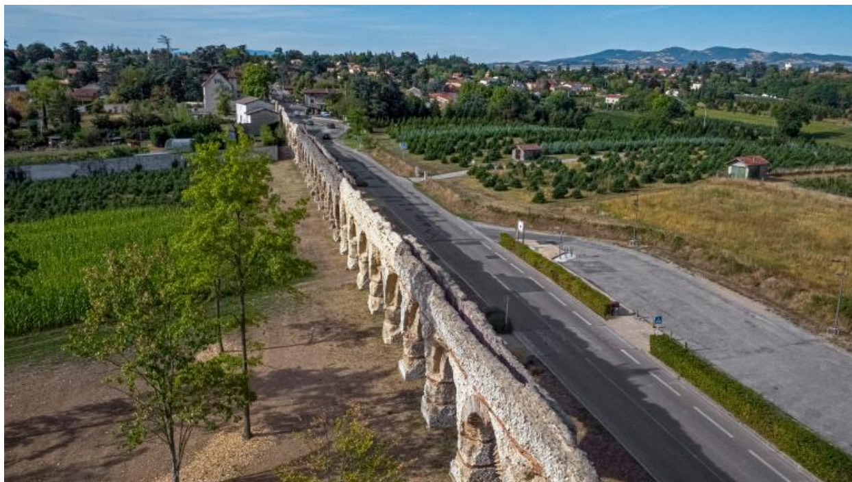
Vue d'ensemble du canal maçonné de l'aqueduc du Gier (partie supérieure) (drône)
