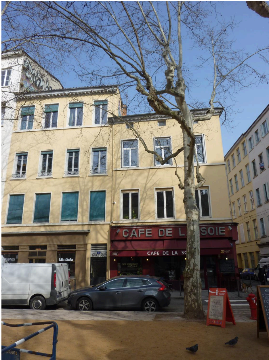
Vue d'ensemble de la façade du 5, 6 place Bertone
