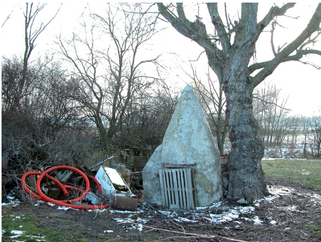
Vue d'ensemble du puits.
