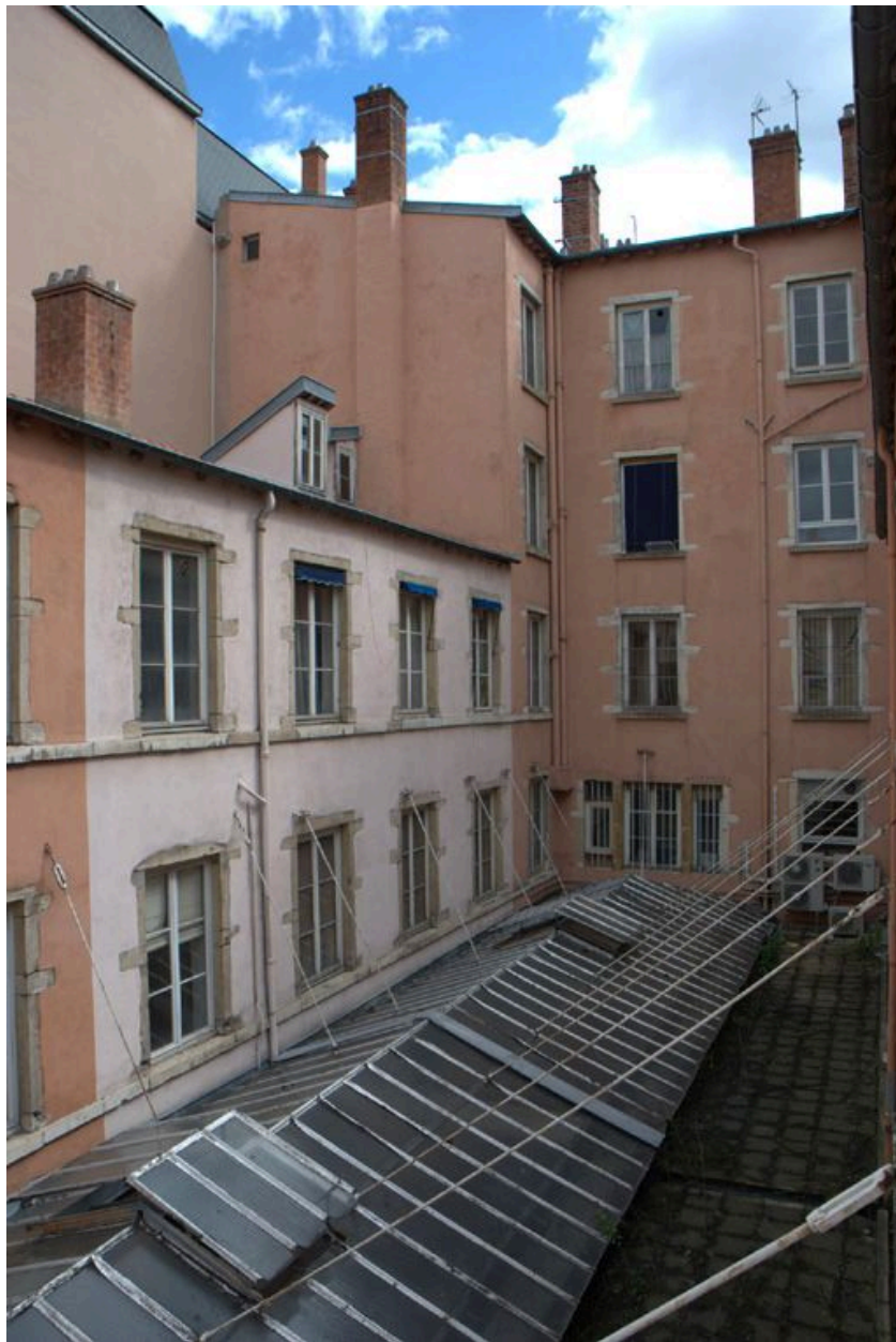
Vue de l'élévation postérieure depuis le sud-ouest
