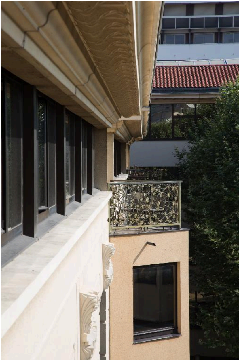
Vue depuis un balcon du quatrième niveau de la façade avec oriel
