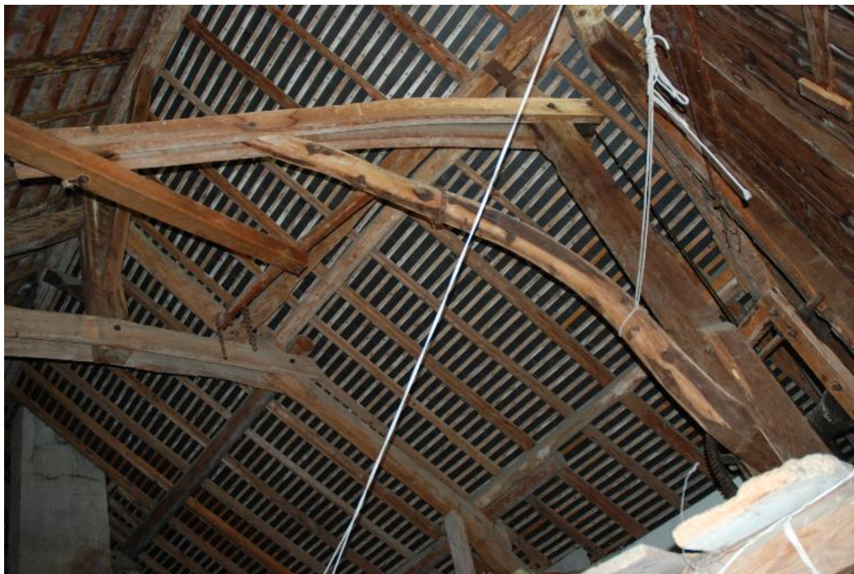
Vue intérieure : charpente.
