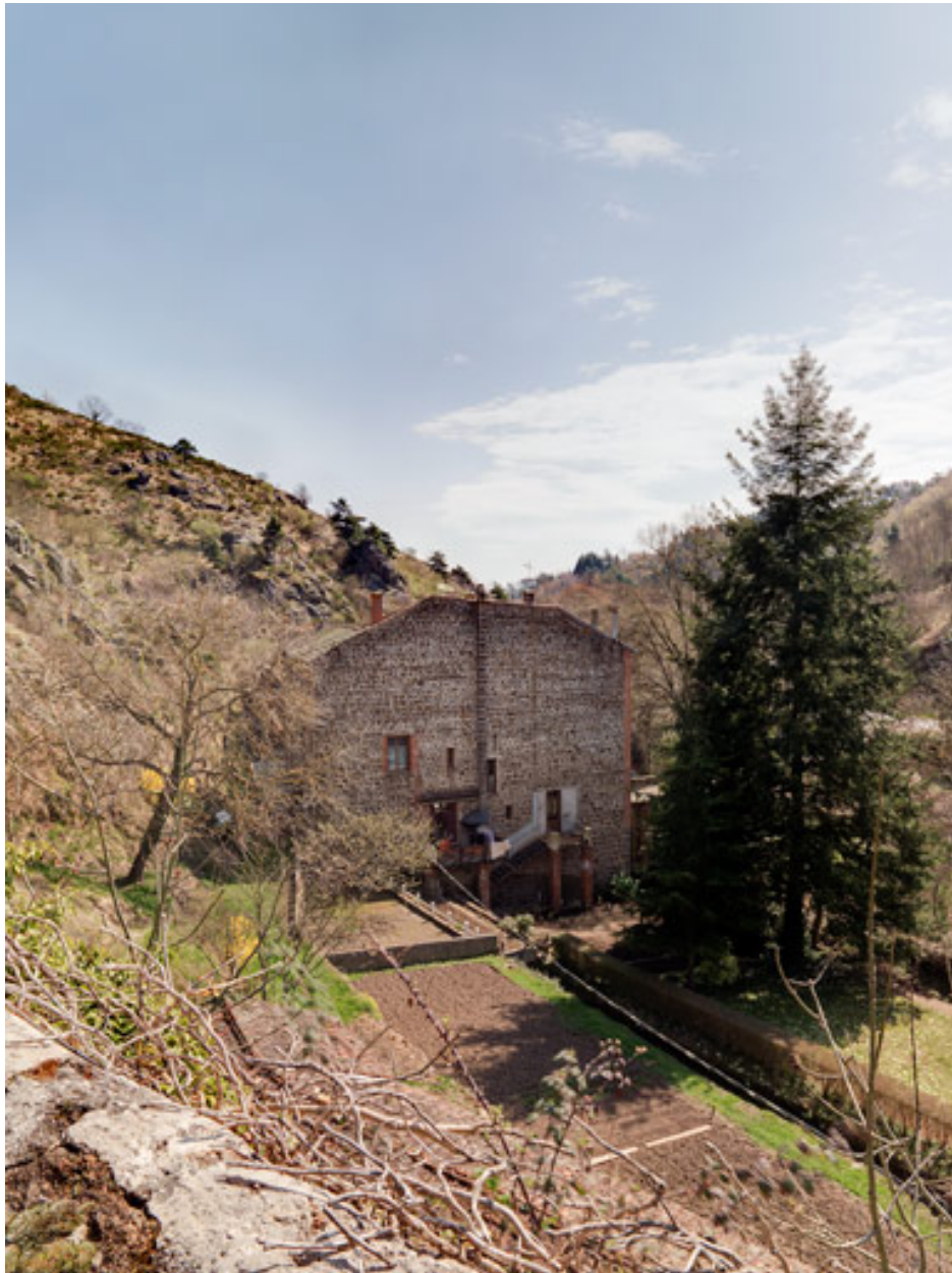
Vue du pignon de la partie habitation, depuis l'ouest.
