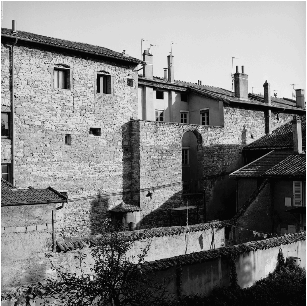
Vestiges des murs réutilisés de l'ancienne chapelle et du couvent.
