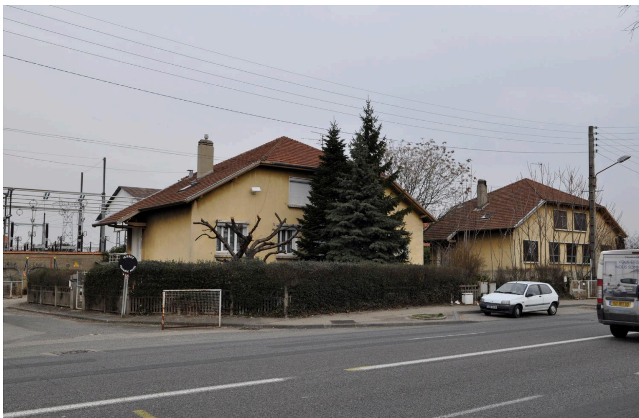
Vue d'extérieur, logements ouvriers, cité EDF
