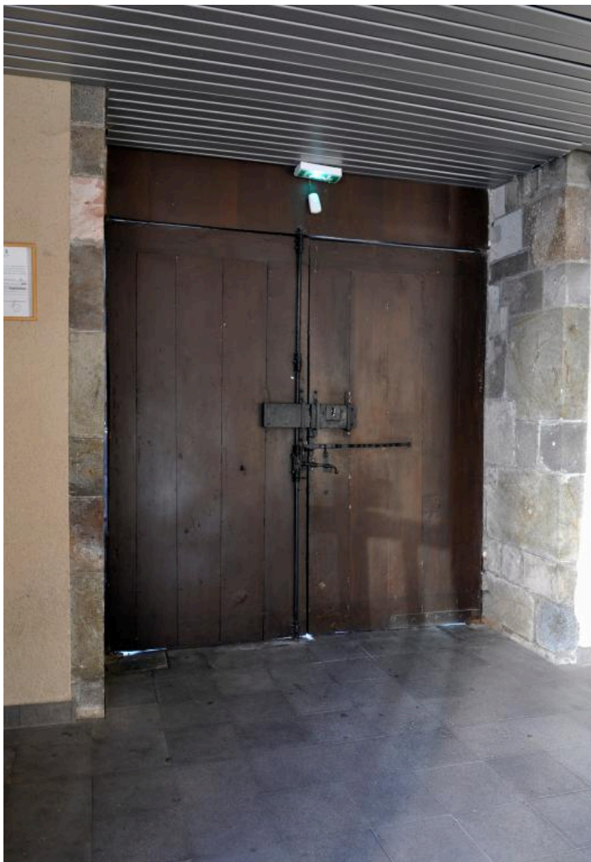
Revers de l'ancienne porte d'entrée de l'église, ouvrant actuellement sur le foyer des lycéens
