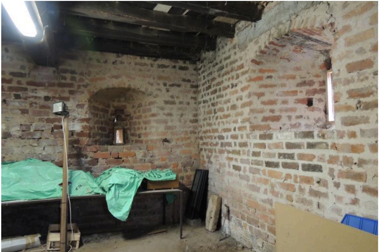
Tour sud-ouest : intérieur, rez-de-chaussée.
