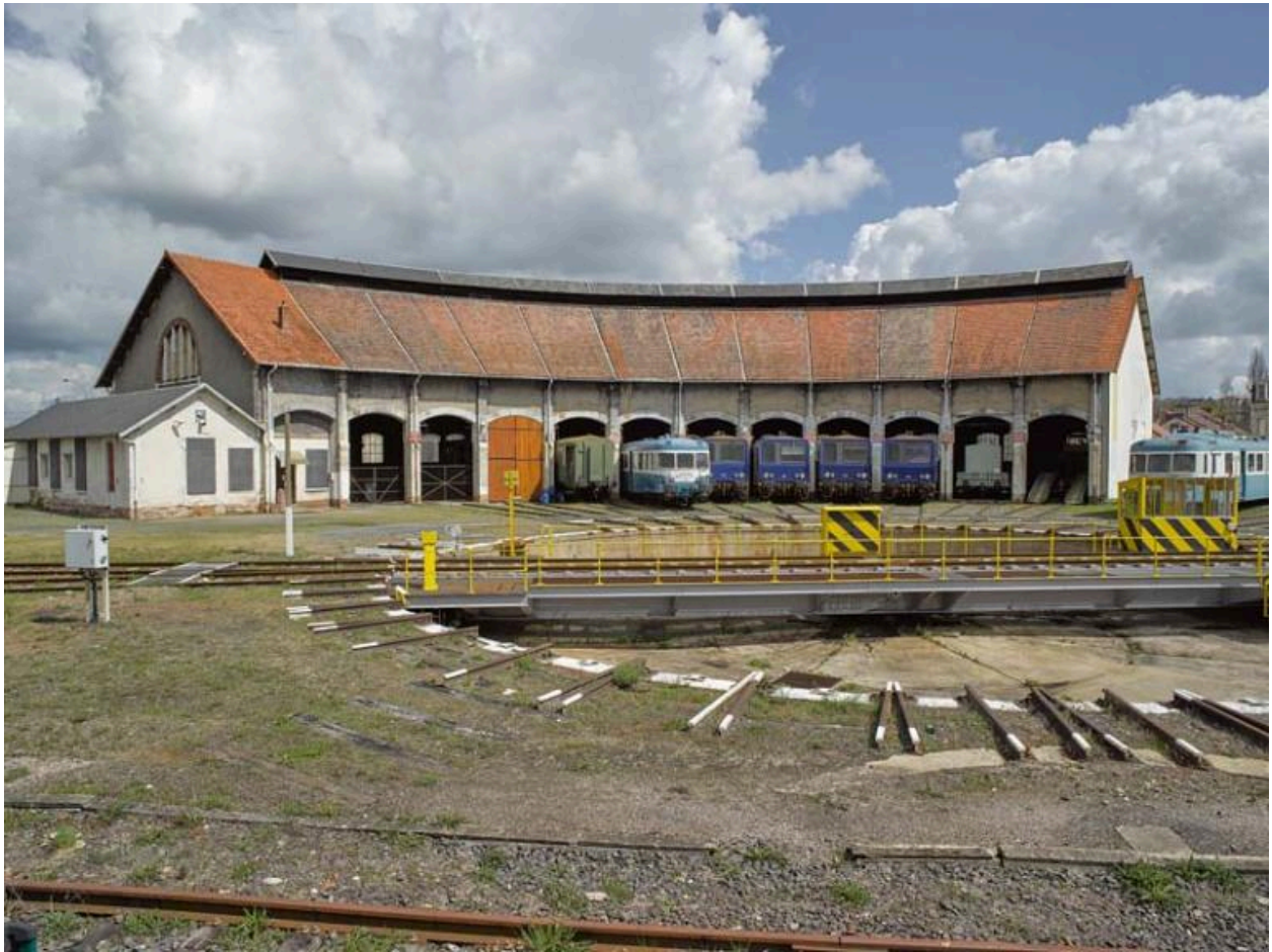
Demi-rotonde ferroviaire avec pont tournant de la gare de Montluçon, de face.
