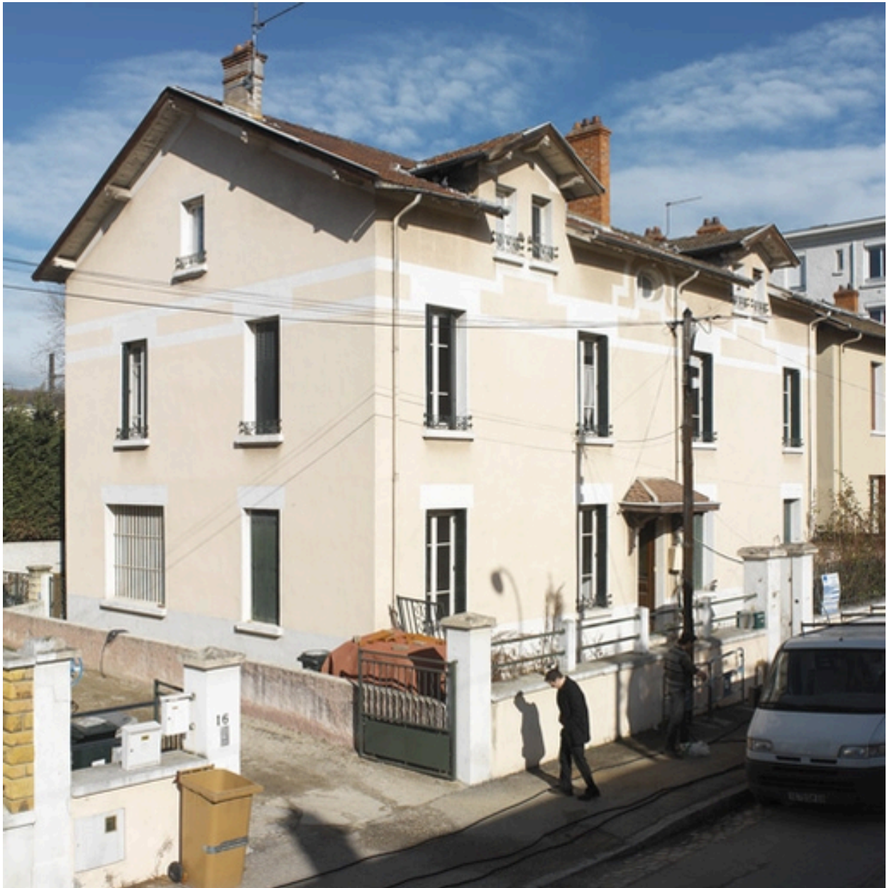
Vue sud, 14 rue Littré (BP 155), maison double devenue maison individuelle, entrée façade principale sud-est
