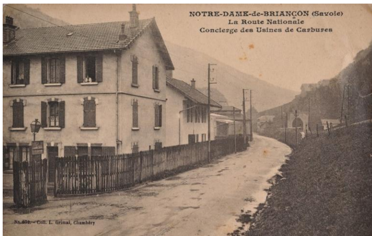
Vue de la route nationale et de la maison du concierge de l'usine de carbure (© Collection particulière M.-A. Podevin).
