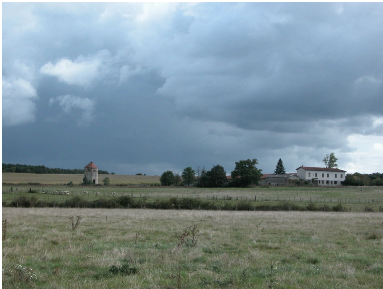
Vue générale depuis le sud.
