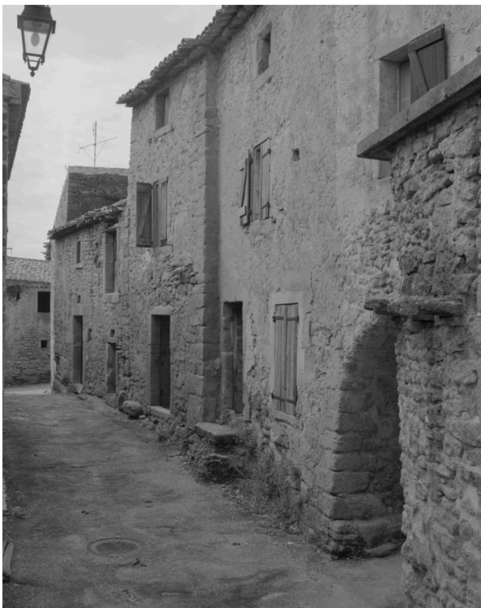
Margerie, traverse du Castel, vue depuis le nord.
