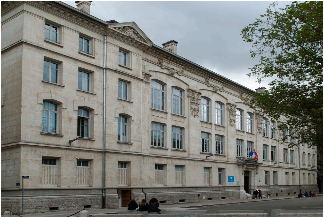
Elévation principale, depuis l'est
