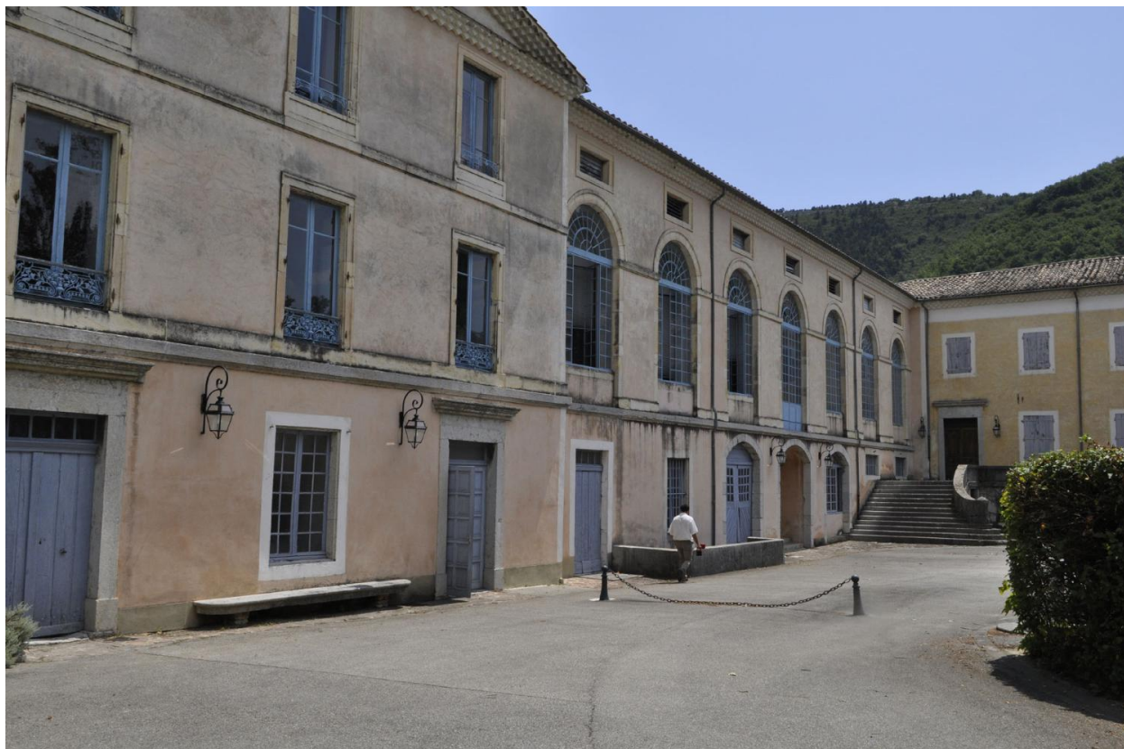
Aile gauche du bâtiment principal, vue d'extérieur
