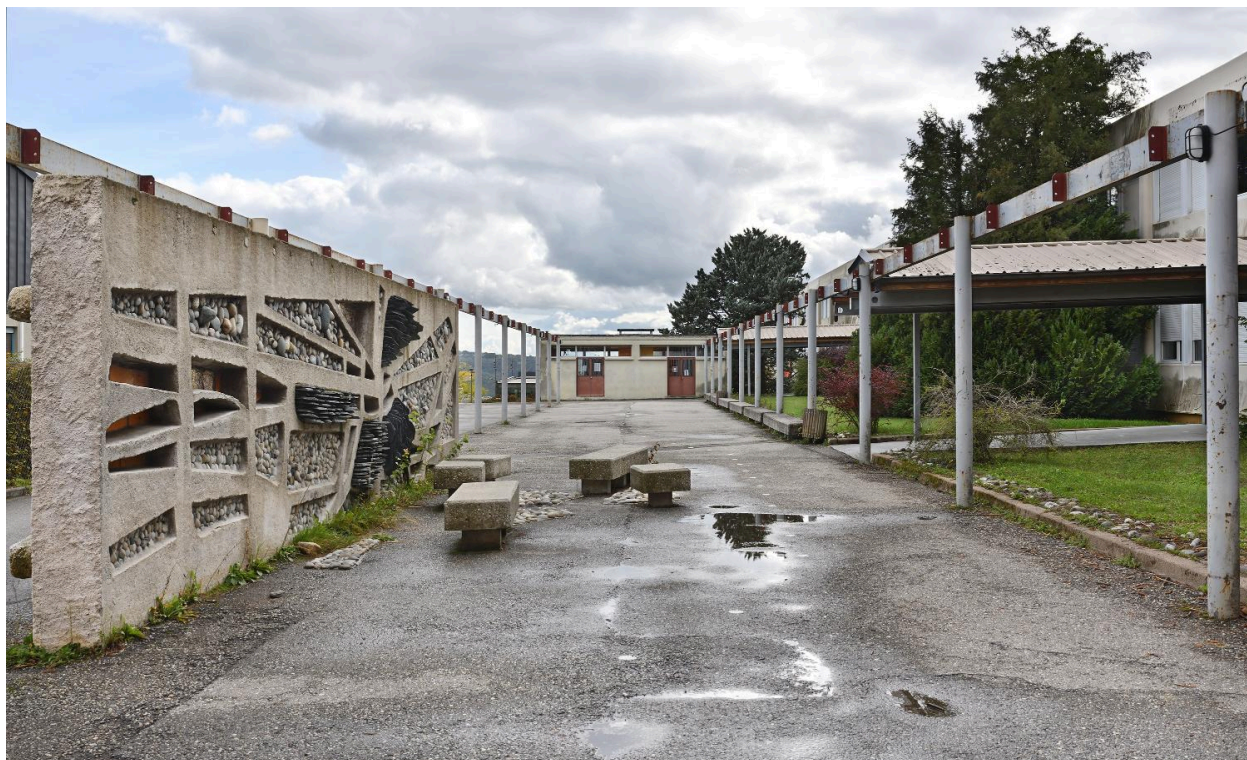
Seconde partie de l'installation, vue de profil.
