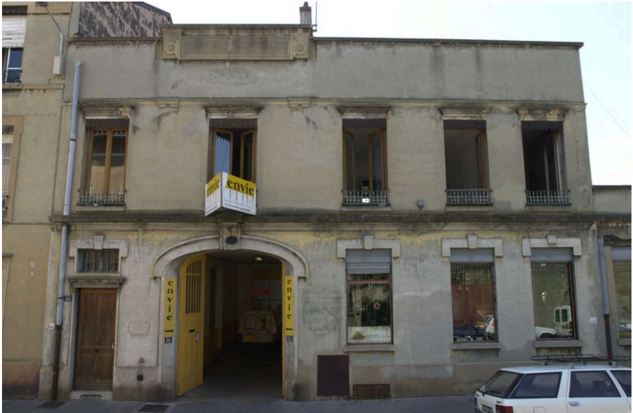
Vue de la façade du bâtiment principal
