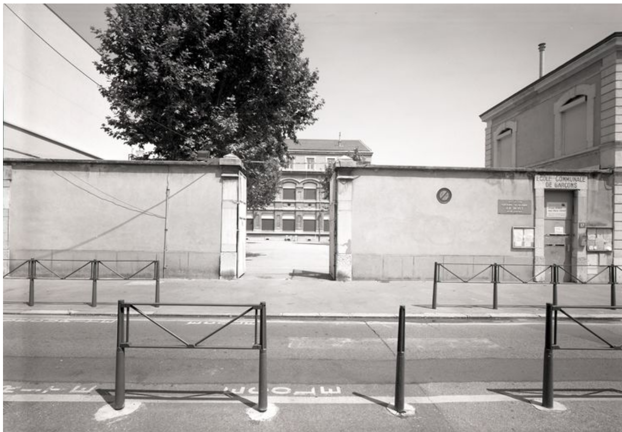
Mur de clôture et entrée, rue du Béguin
