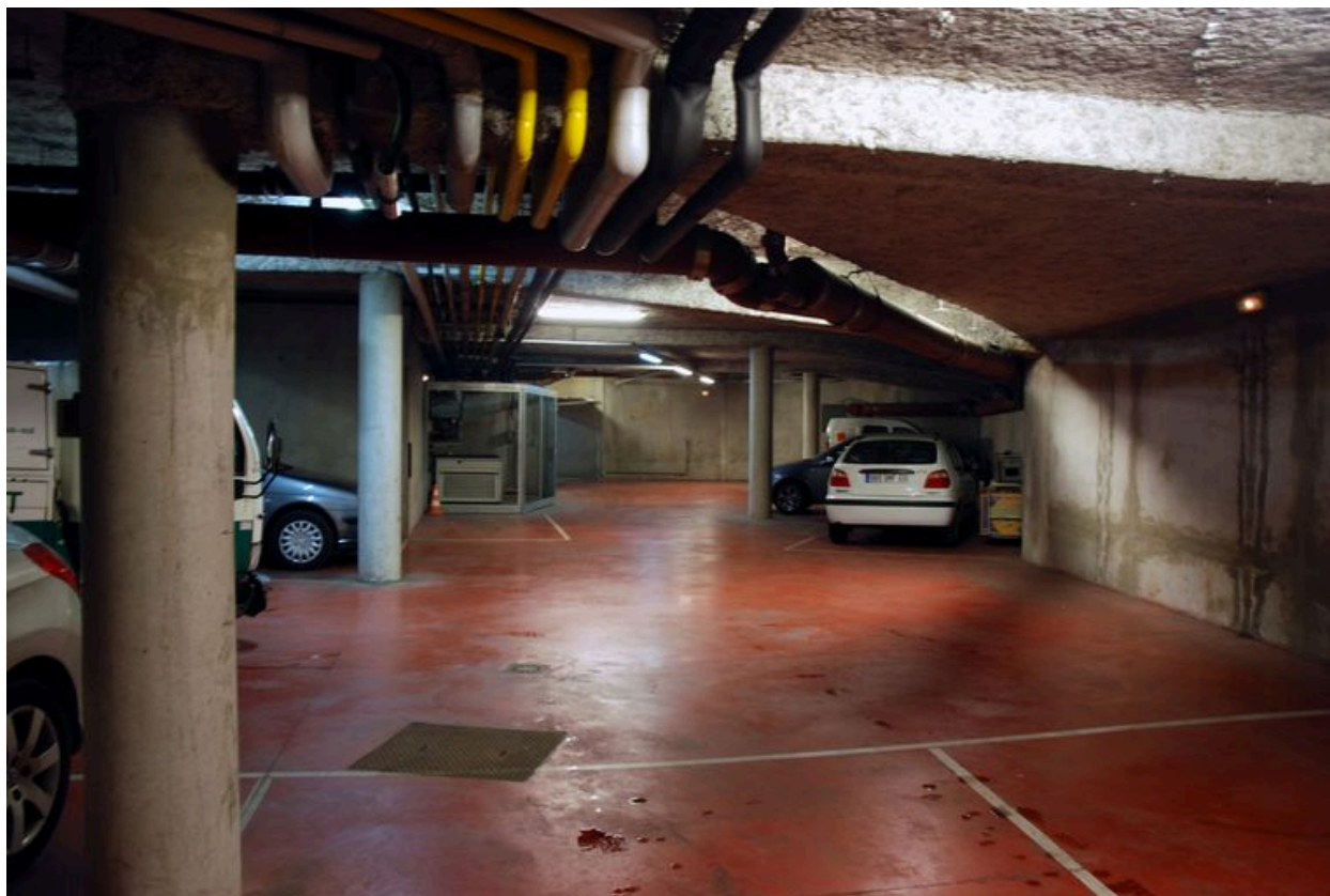
Bâtiment A : garage (sous-sol)
