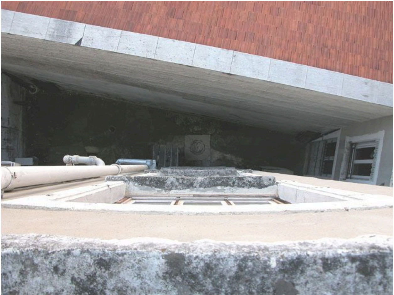
Vue de la cour depuis la cage d'escalier
