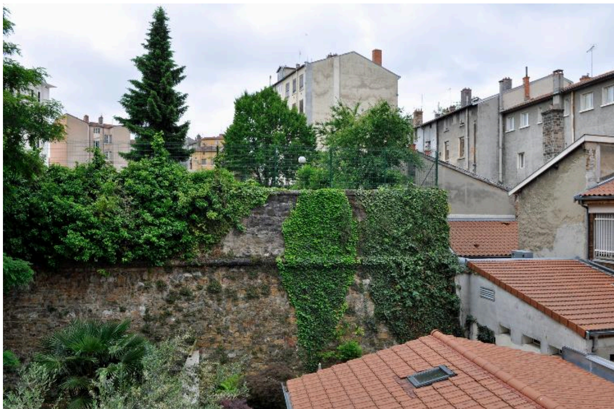
Vue du mur d'escarpe, depuis le 8 rue d'Austerlitz
