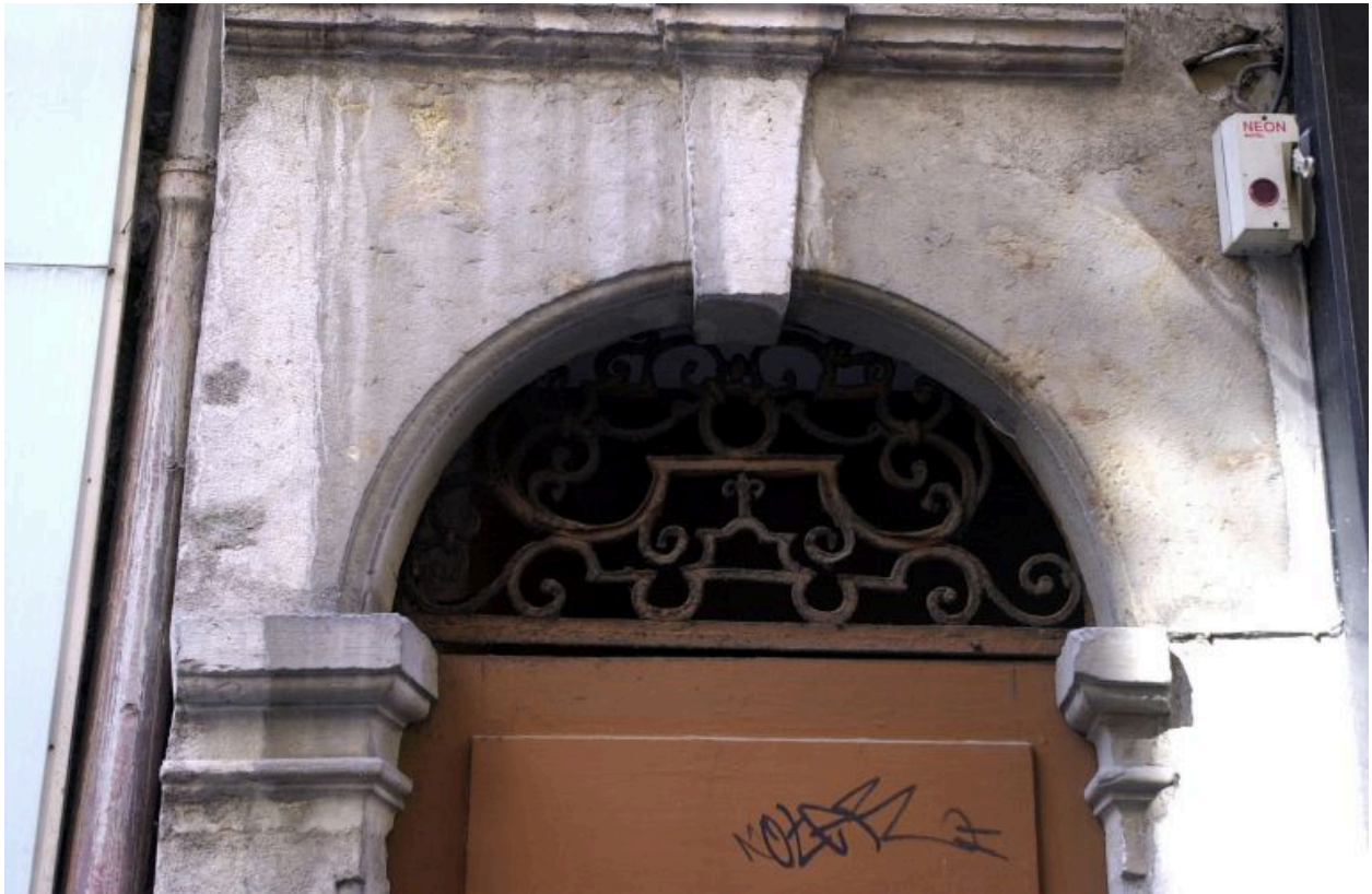
Façade sur rue, porte, détail de la grille d'imposte
