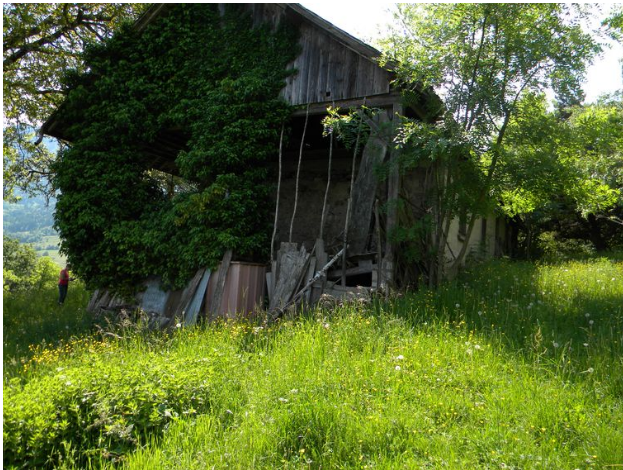
Vue de la façade nord.
