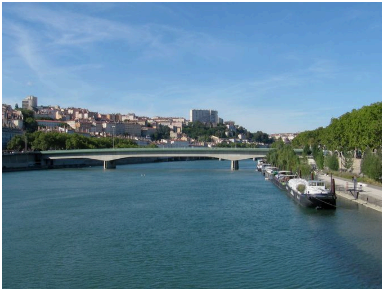
Vue générale, face aval (depuis la passerelle du Collège)
