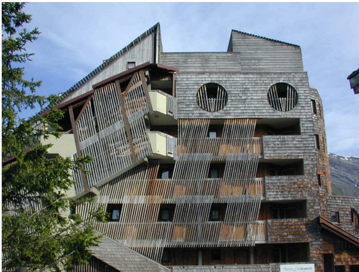
Elévation nord : détail de la partie est
