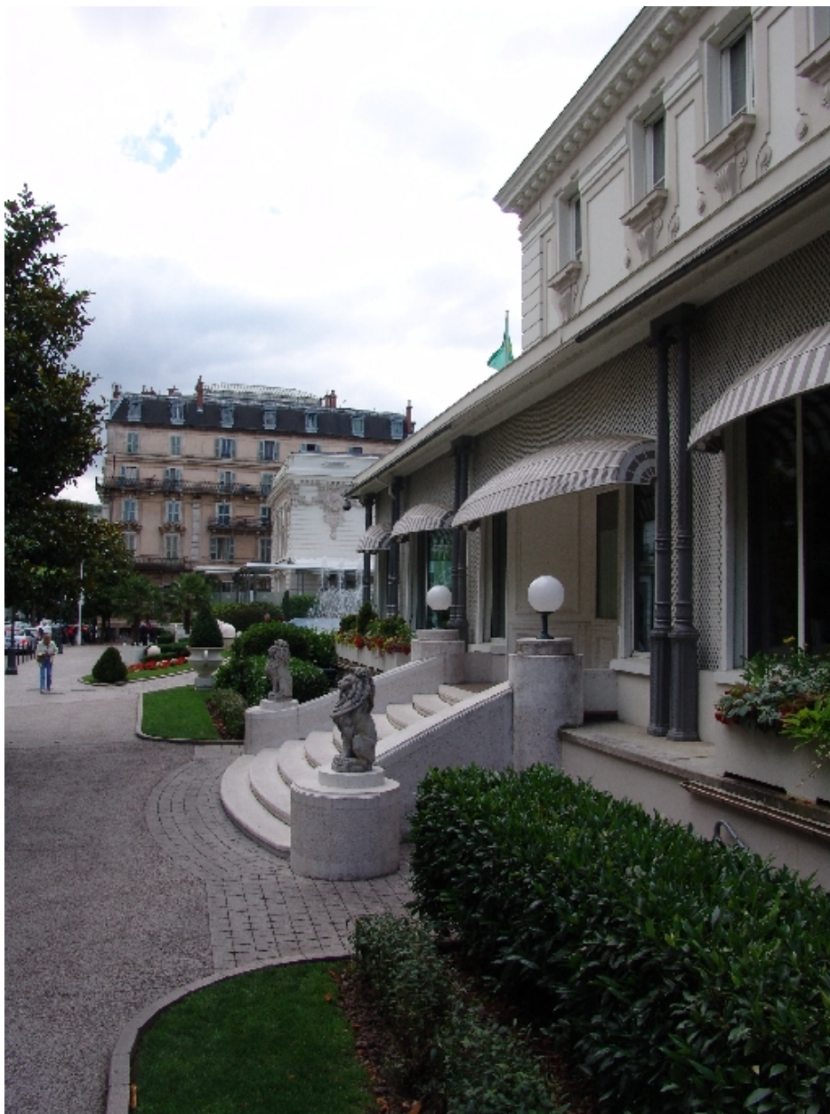
Pavillon nord, façade sur rue
