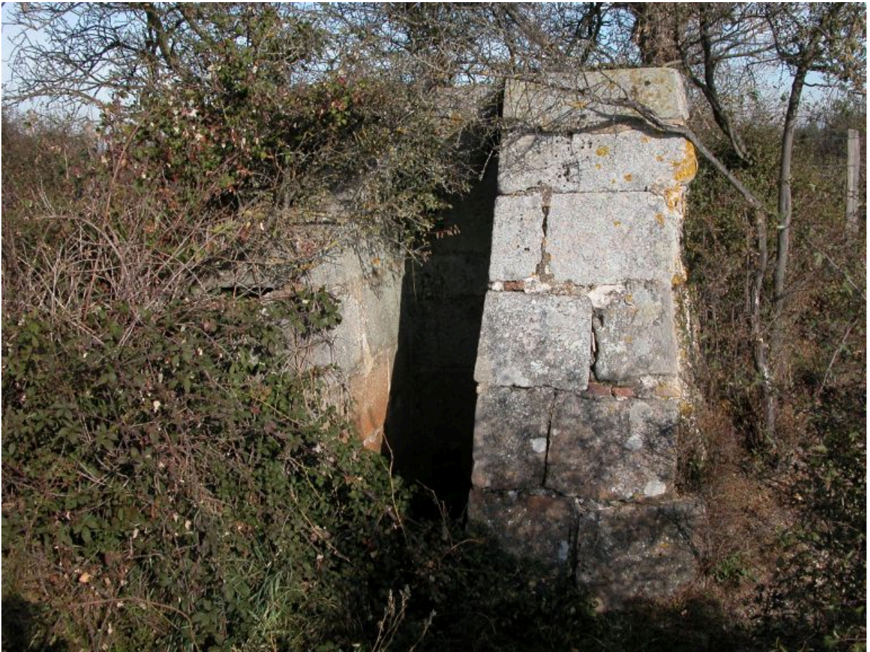
Sous Grumard, 1986 AP 23. Massifs maçonnés non identifiés.
