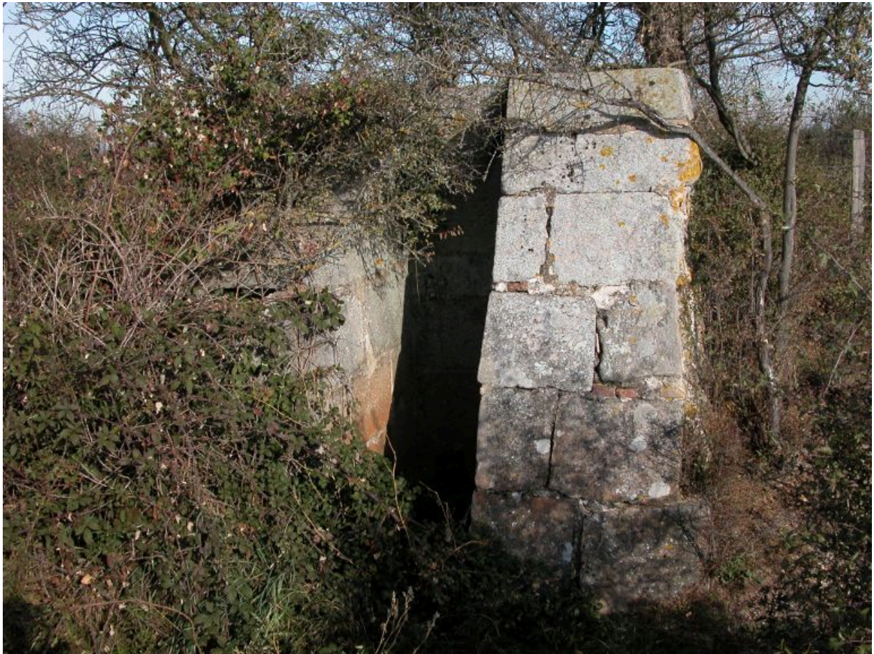
Sous Grumard, 1986 AP 23. Massifs maçonnés non identifiés.
