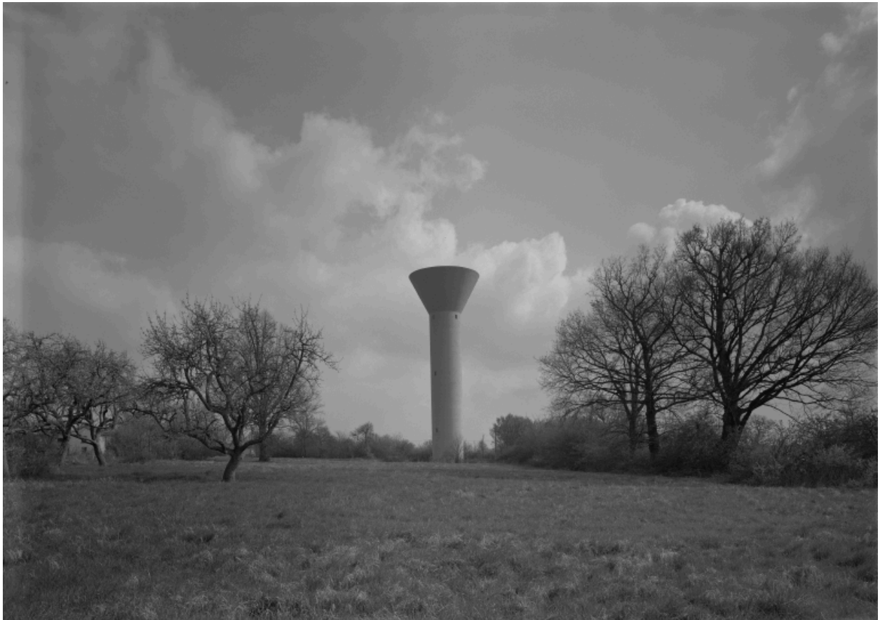
Vue du château d'eau (Cétéreau, 1986 C3 523).
