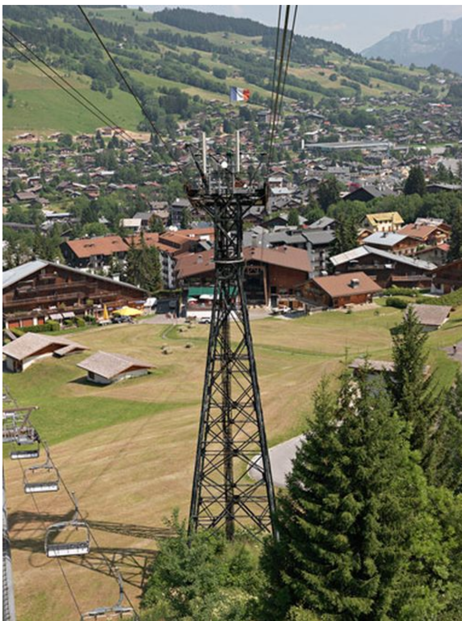
Le dernier pylône avant la gare inférieure depuis l'amont
