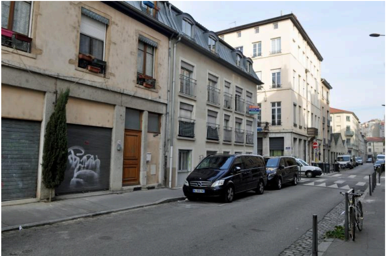
Vue de la partie nord de la rue Chalopin (au droit du n°18)
