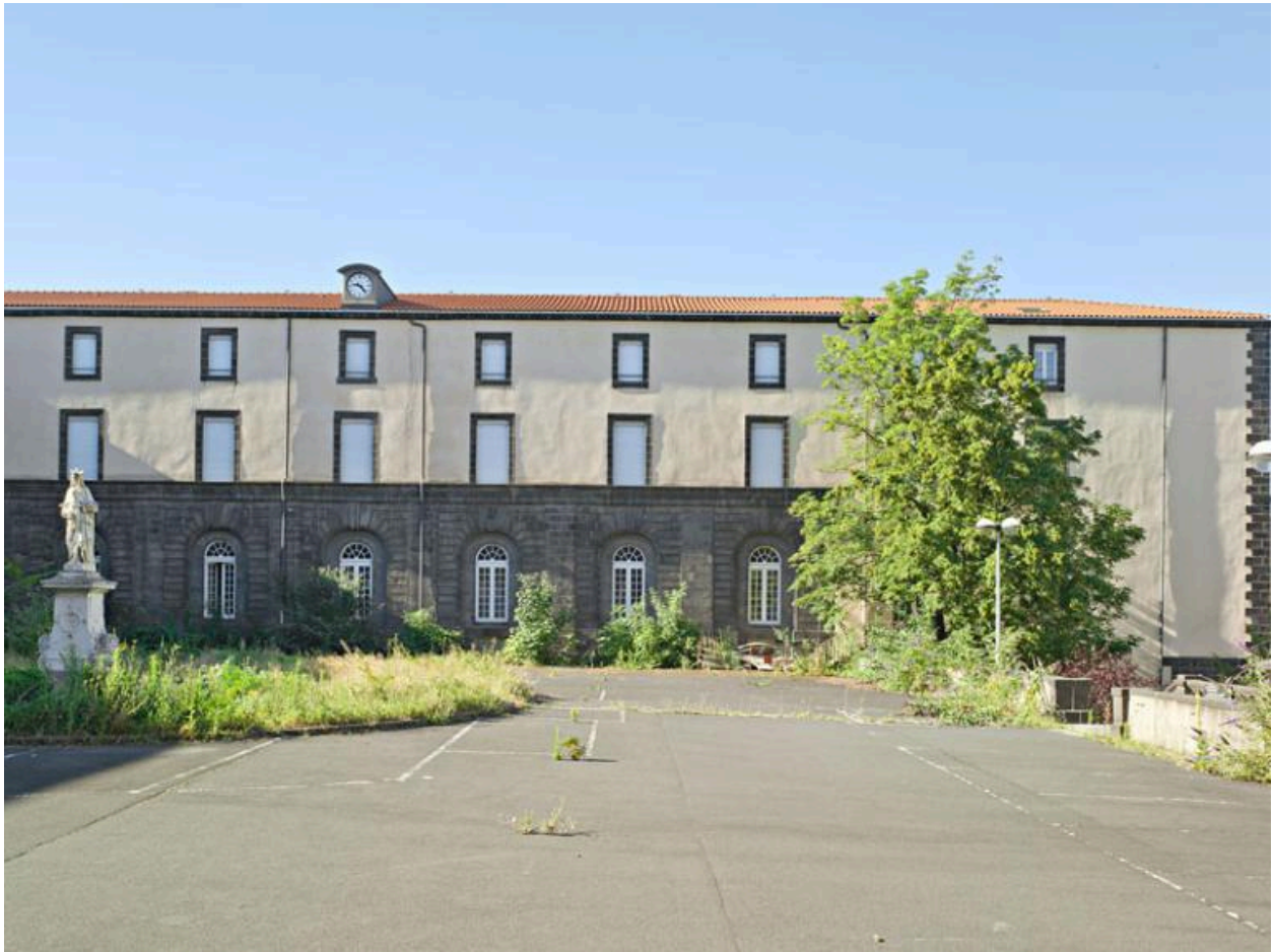
Hôtel-Dieu de Clermont-Ferrand. L'hôtel-Dieu, corps de bâtiment médian, façade nord (centre et côté droit).
