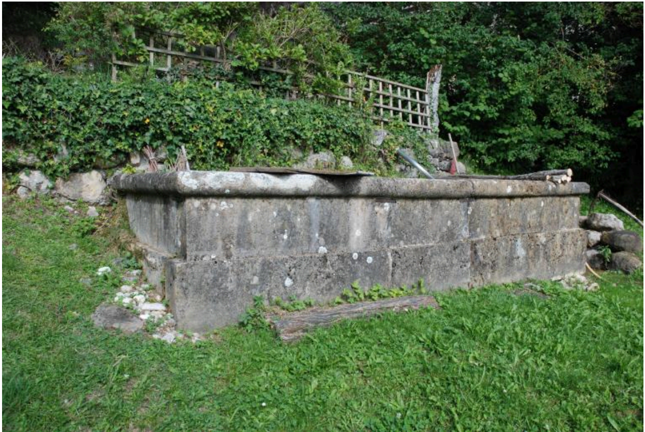
2015 C6 435, bassin. Vue d'ensemble
