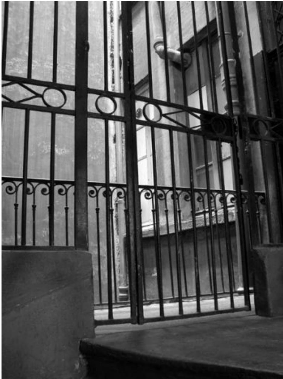
Escalier, palier du 3e étage, grilles séparant l'escalier de la coursière
