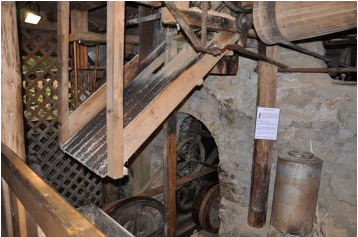
Mécanisme de la battante situé en sous sol
