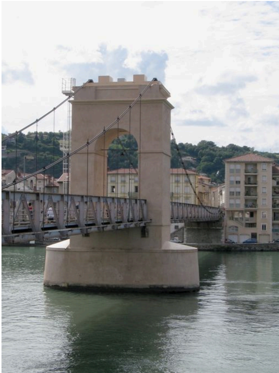
Vue partielle, pile centrale et travée droite, face amont (depuis la rive gauche)
