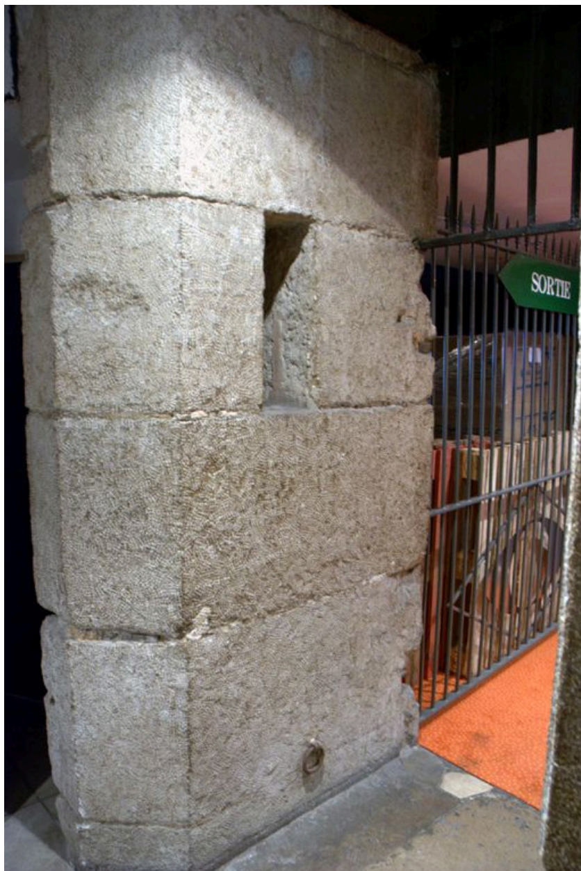
Mur porteur de l'immeuble au débouché de l'escalier en équerre desservant le sous-sol (actuel escalier de sortie de la salle 1)
