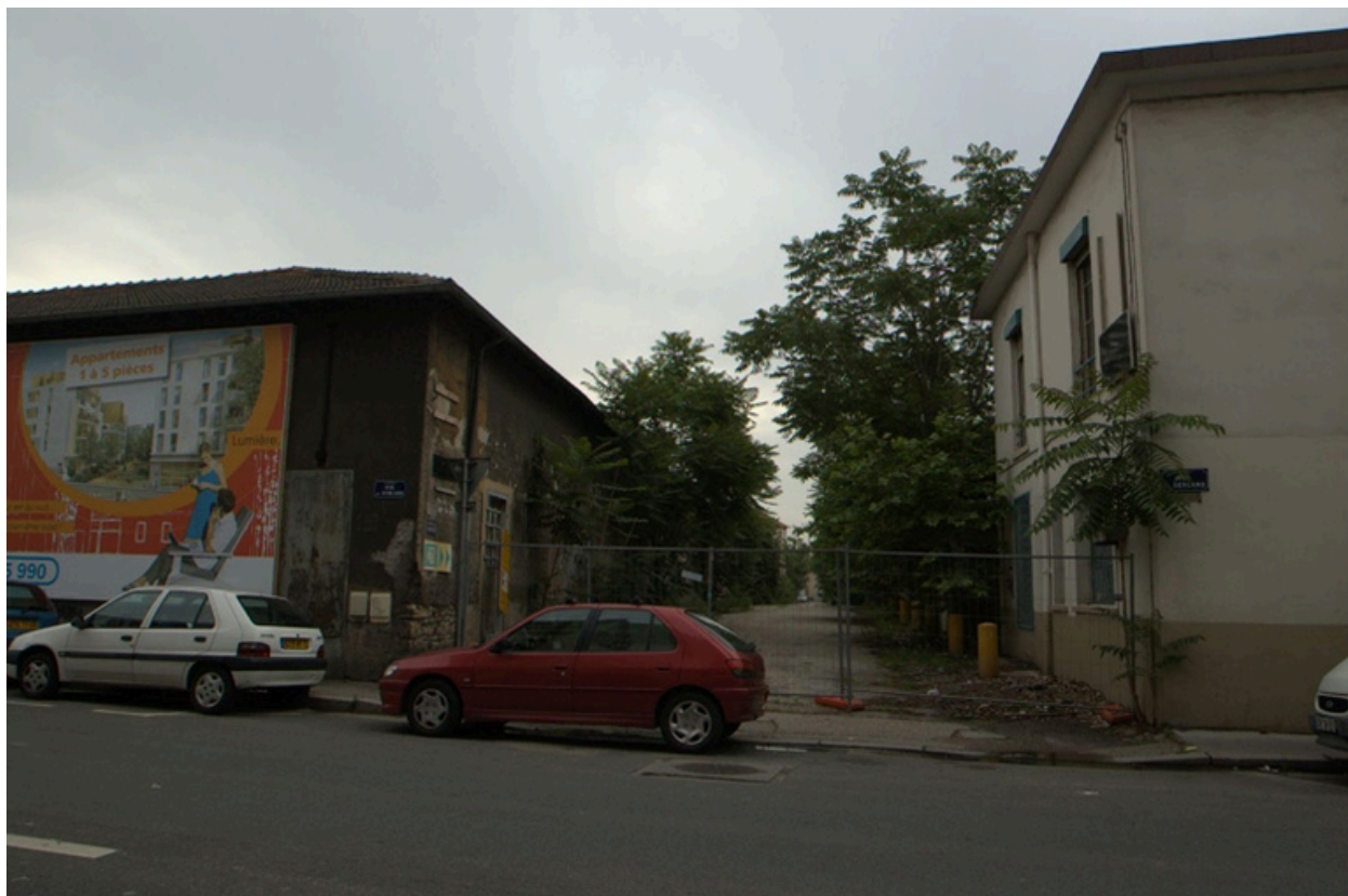
Vue sud-ouest angle avec l'impasse Faugier
